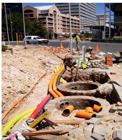
Figura 1 - Instalação de cabos de fibra óptica
