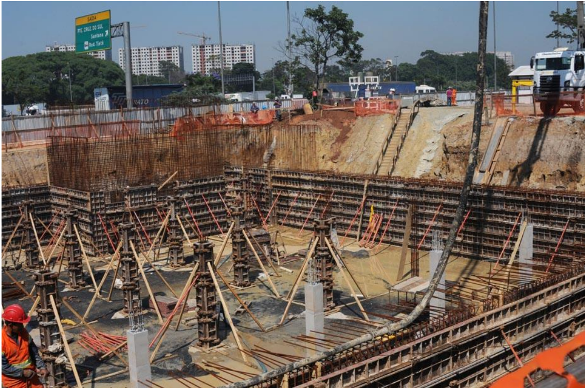
Foto 6.6.3-2 – Construção de pôlder na margem direita da Marginal Tietê (Ponte da Vila Maria).
