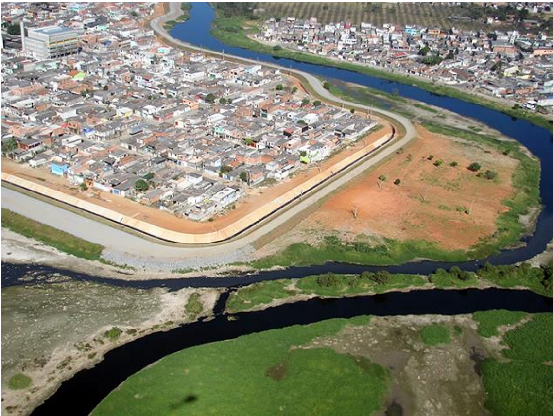
Foto 6.6.4-1 – Imagem aérea do dique de contenção do Jardim Pantanal.
