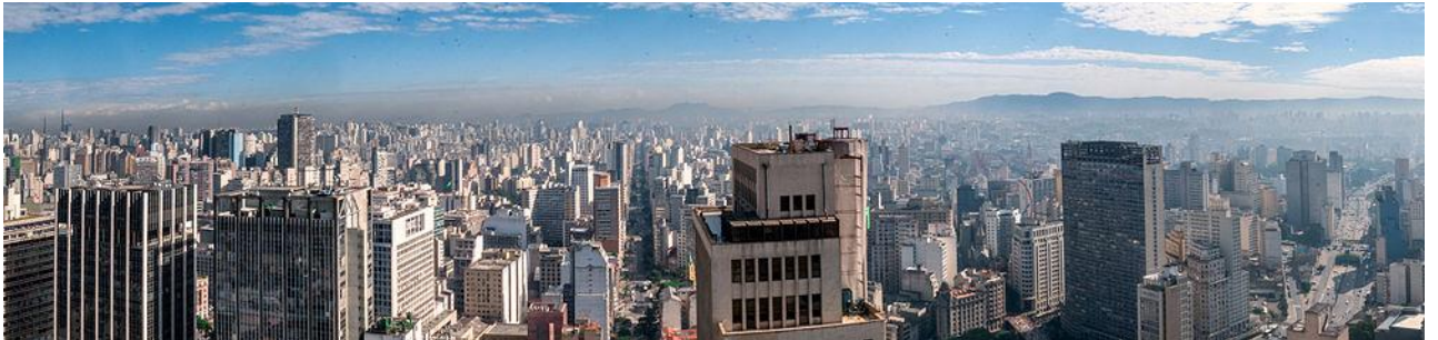
Figura 5 - Panorama da zona central da cidade de São Paulo a partir do edifício Altino Arantes. Fonte: Wikipedia, acesso: 03/12/2017
