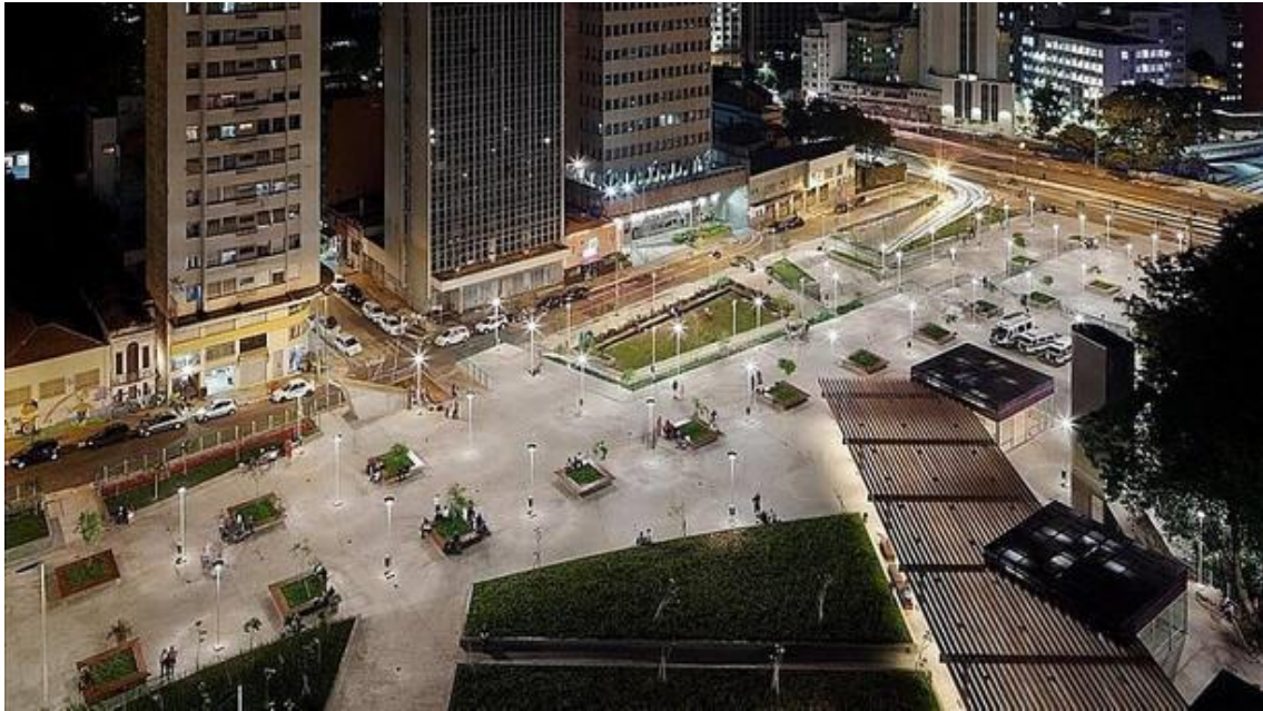
Figura 4 - Praça Roosevelt após a reforma. Foto: Carlos Fortes, site: estadao.com.br/acesso:outubro/2017
