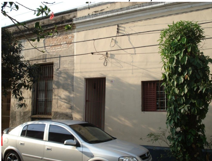
Figura 3 - Alisamento da fachada e substituição de janela na casa à direita.
