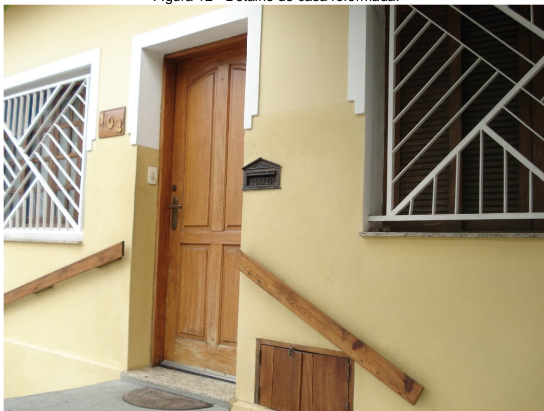
Figura 12 - Detalhe de casa reformada.
