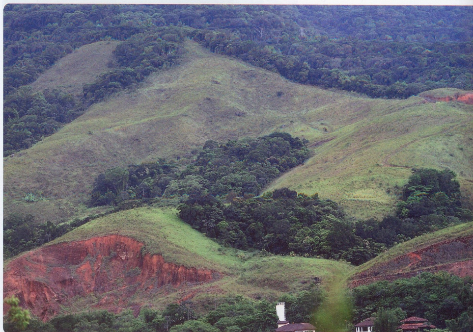
▲ Quando a cobertura vegetal é retirada, uma das primeiras consequências é a erosão. Na foto, de 2009, processo erosivo instalado em encostas de morros que foram desmatados em São Sebastião, no litoral de São Paulo.
