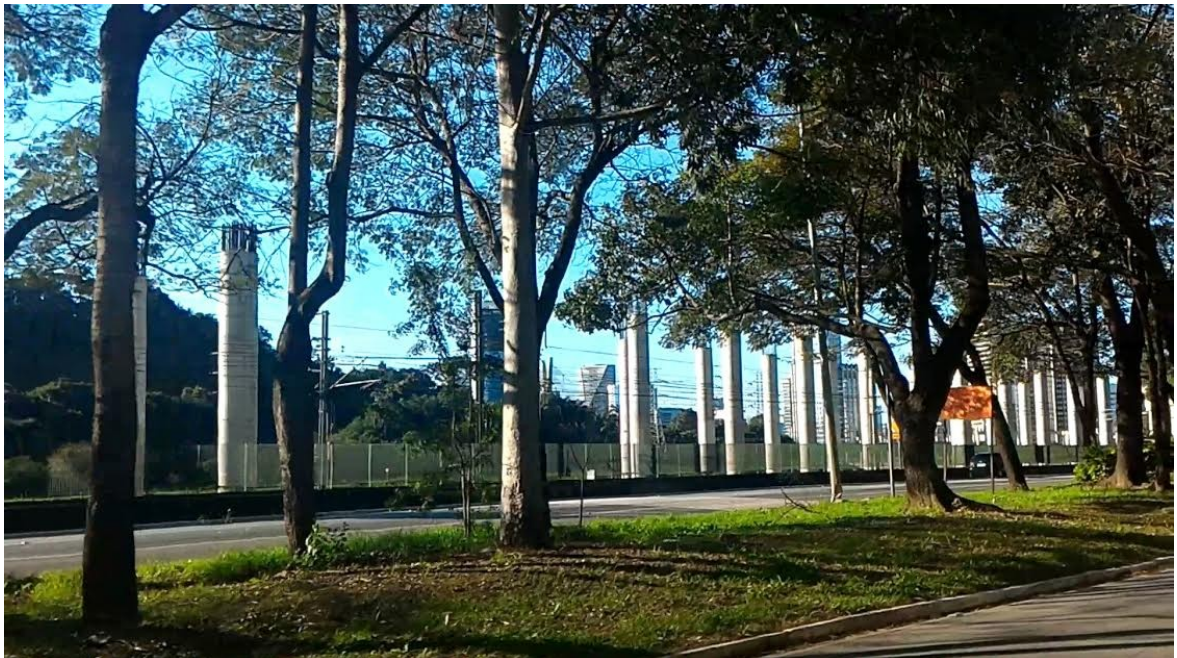
Figura 2 – Na imagem, verificamos as vigas por onde circulará o Monotrilho, nas imediações de onde será instalada a Estação Morumbi, acompanhando a Marginal Pinheiros. Fonte: autora, março de 2017.
