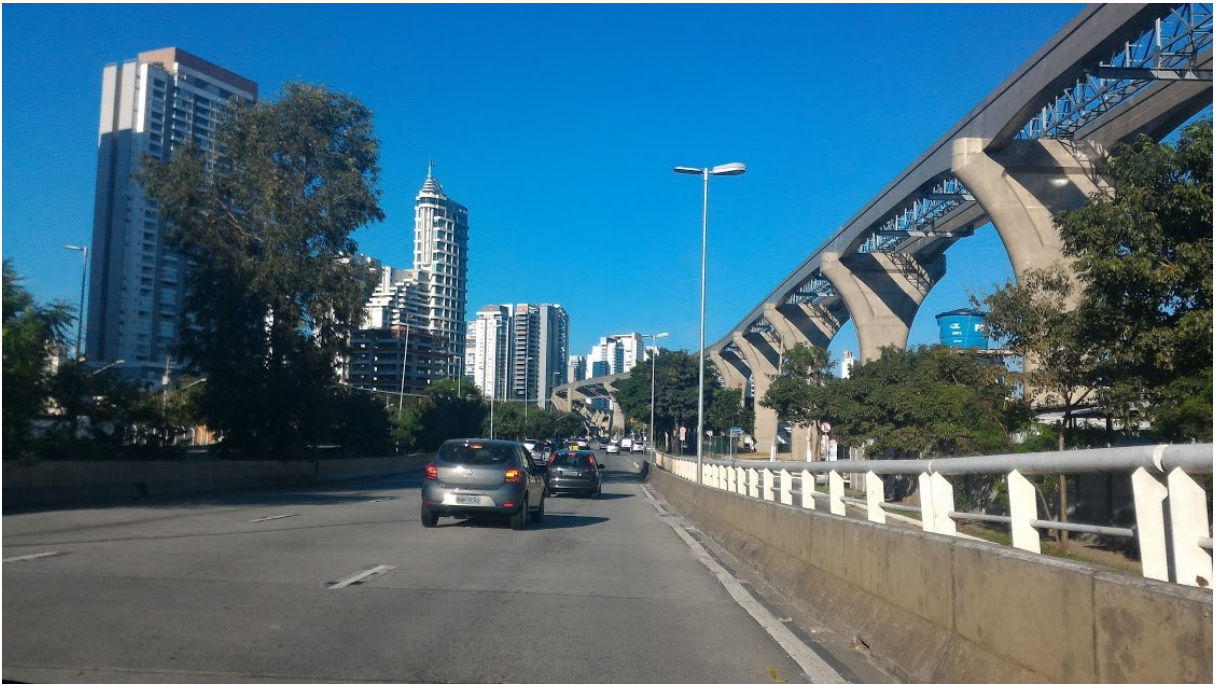
Figura 3 – Proximidades de onde será instalada a Estação Chucri Zaidan. Nessa imagem, é possível constatar o Monotrilho como via de circulação, inscrito no espaço urbano. Fonte: autora, junho de 2017.
