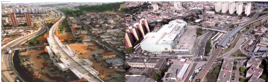
Figuras 7 e 8: a estação do Campo Limpo ainda em obras em 2001 (esq.) e a estação já consolidada em 2013. Fonte: Metrô (2003) e Metrô (jun.2013 23 ).
