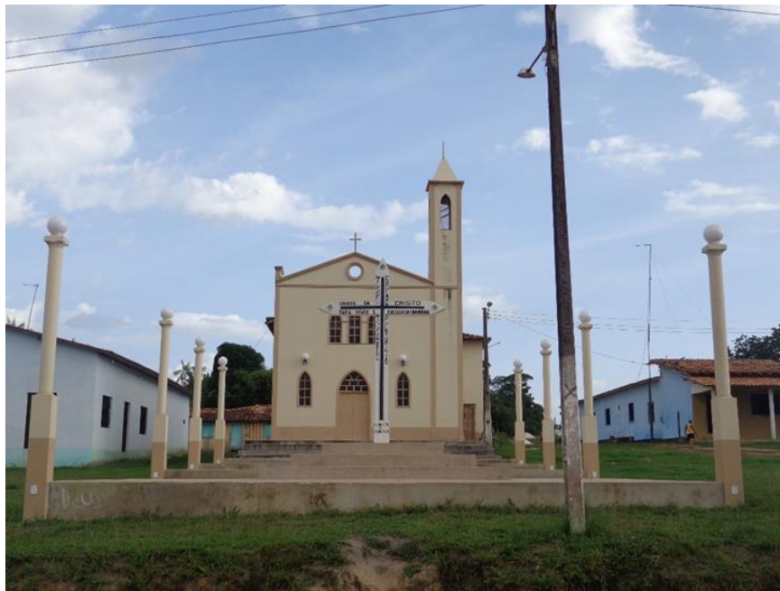
Figura 14: Igreja da comunidade Vila do Cravo. Fonte: Anjo, 2015
