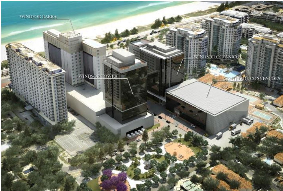
Figura 28: Complexo de hotéis da rede Windsor junto a um centro de convenções pertencente a ela
