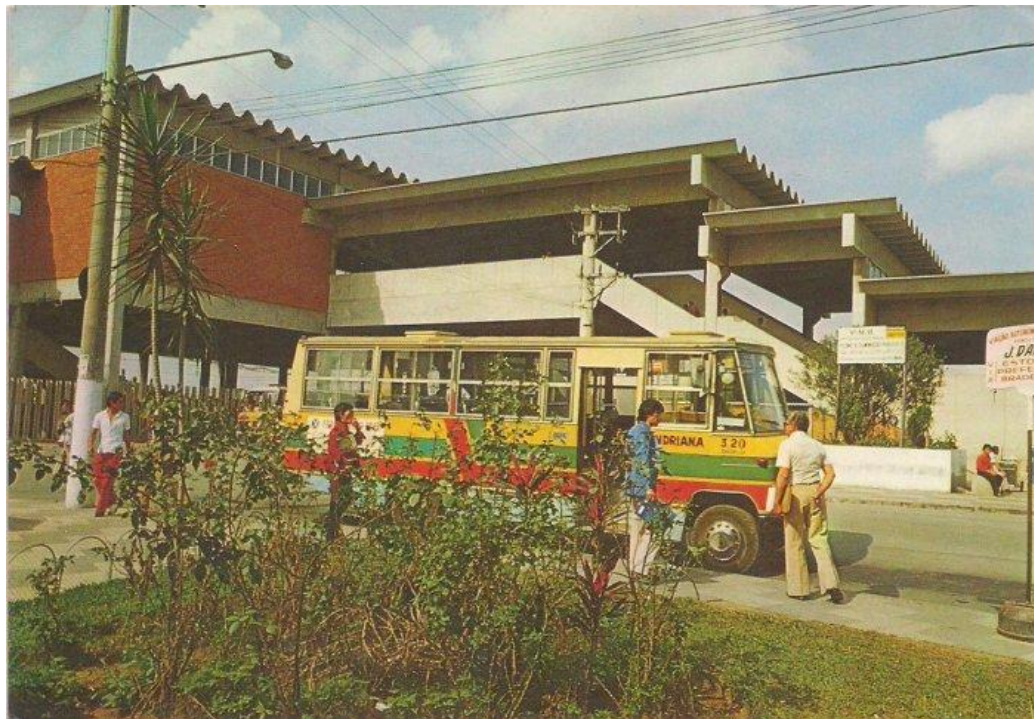
Figura 19: A estação de Osasco após a reforma da FEPASA. O prédio da estação ainda mantém muito dessa fisionomia. Foto de um cartão postal. FONTE: Estações Ferroviárias do Brasil, 2013.
