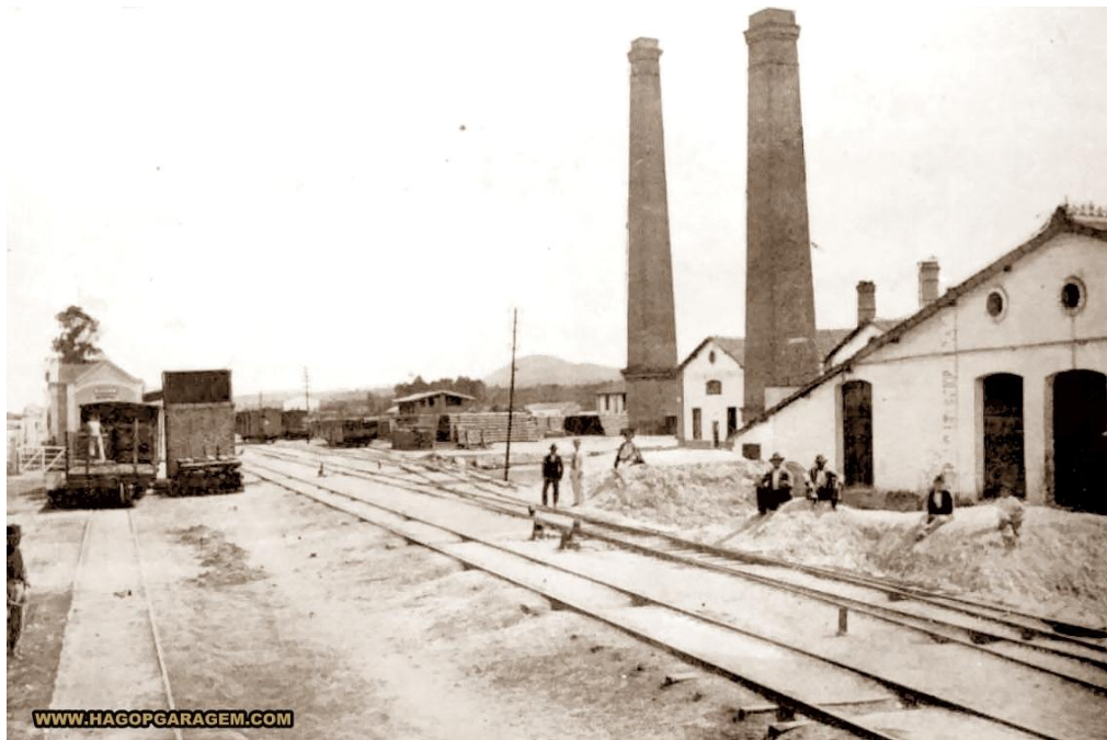
Figura 09: Cerâmica Industrial de Osasco (Hervy) no início de século XX. Localizada à direita. Atenção para a linha férrea sem grades e barreiras de proteção para o trem. Acervo Hagop Koukdjian Neto.
