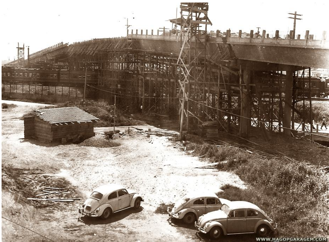
Figura 17: O Viaduto Dona Ignês Collino sendo construído na década de 1960. Detalhe para o trem passando embaixo do viaduto. Essa construção é uma maneira de superação da linha férrea para favorecer a mobilidade em Osasco. Acervo Hagop Koukdjian Neto.
