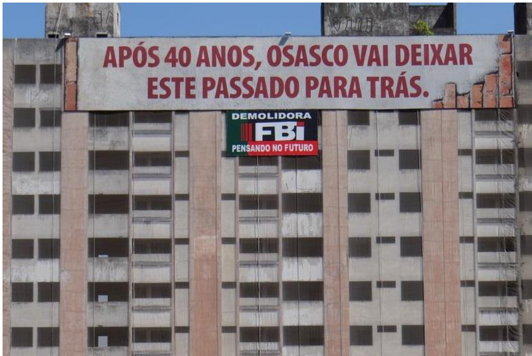
Figura 28: Prédio do conjunto Nova Grécia antes de ser demolido. Destaque para a frase na faixa no prédio “Osasco vai deixar esse passado para trás. Detalhe na placa da empresa demolidora, “pensando no futuro”. Fonte: Demolidora FBI (2013).
