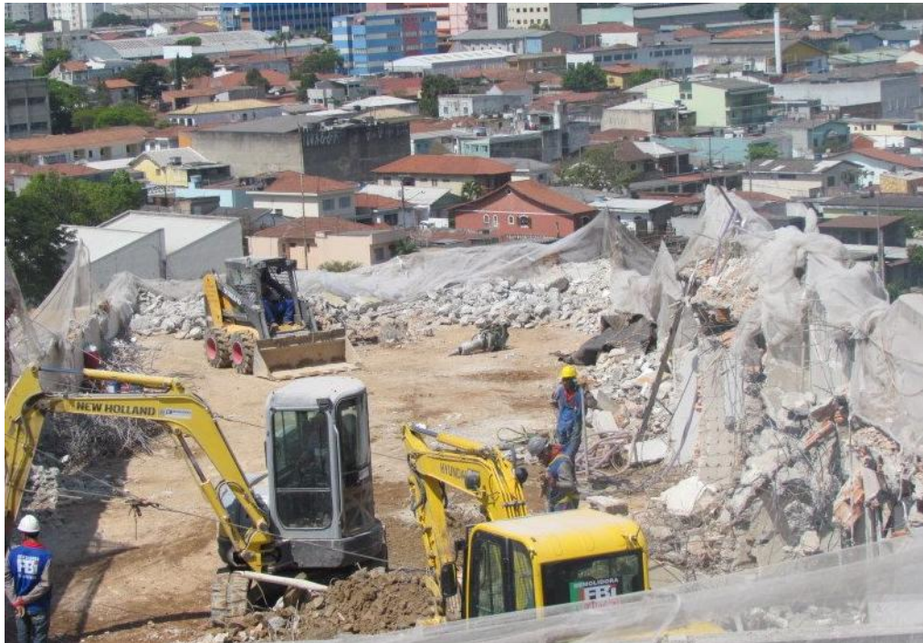
Figura 29: Prédio do conjunto Nova Grécia em demolição. Fonte: Demolidora FBI (2013).
