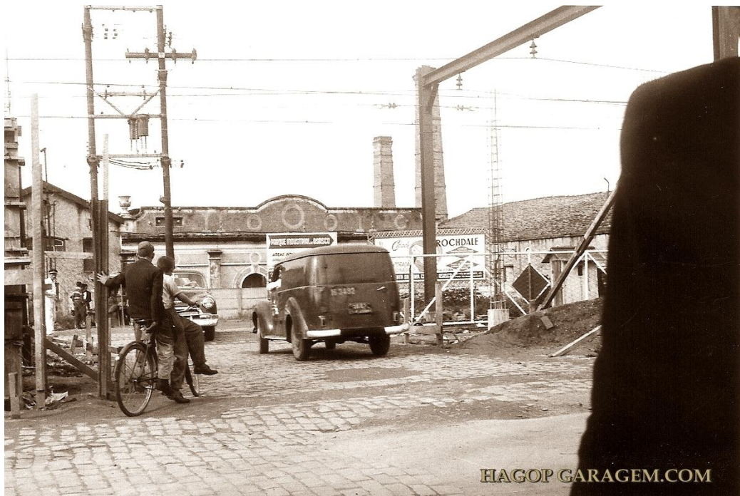
Figura 18: Antiga portaria do trem na década de 1960 na Rua André Rovai. Ao fundo, a Hervy. Acervo Hagop Koukdjian Neto.
