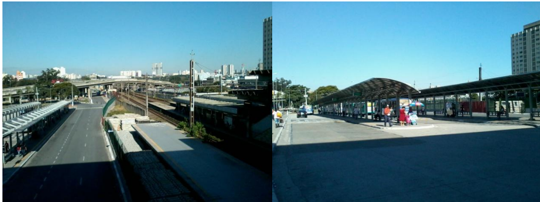
Compilação de Fotos 02: Rodoviária de Osasco após a reforma, com interligação com a estação de trem. Fotos de: Leonardo Araujo Cardeal da Costa. 31 de Julho de 2013.
