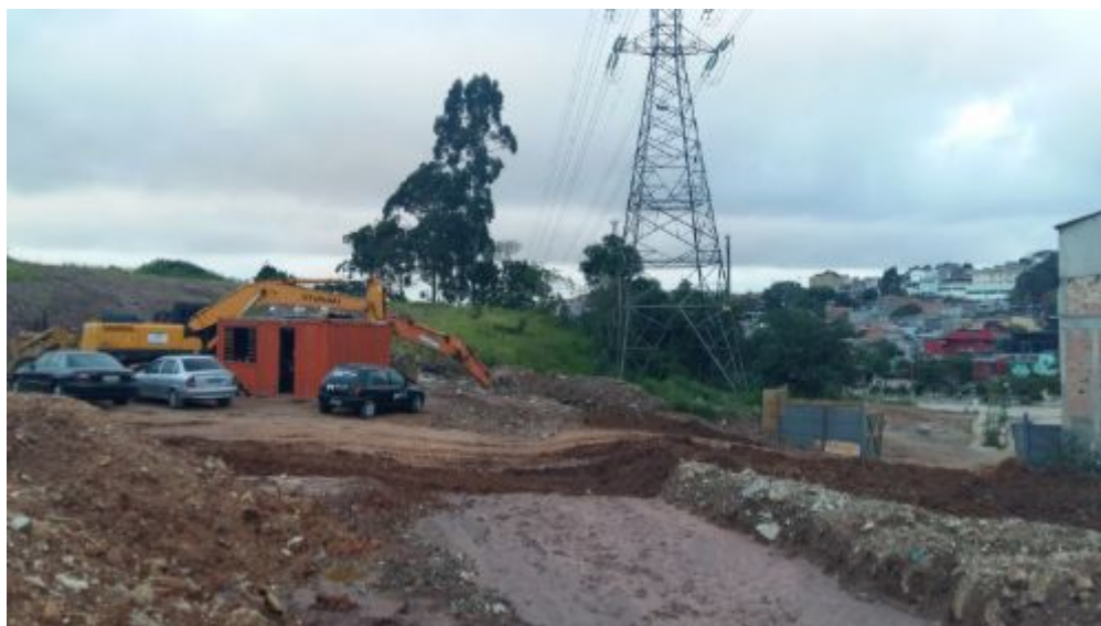
Foto 6. Terraplenagem e máquinas no terreno. Autoria: Julia Carlini. Março/2016.
