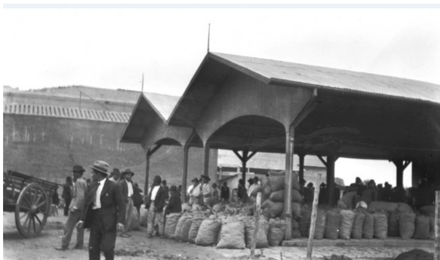
Mercado dos Caipiras, anos 1900 - Raul Goldschmidt – Local onde tropeiros expunham seus produtos, dos quais a batata se destacava, batizando a região de Largo da Batata. O endereço ainda existe, como Mercado Municipal de Pinheiros, Rua Pedro Cristi, nº 89. Hoje atende a alta classe da região, com restaurantes sofisticados e gourmets.
