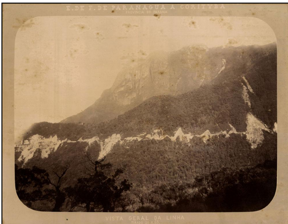
Figura 2 – Obras na ferrovia. (Foto: Marc Ferrez / Arquivo Biblioteca Nacional)
