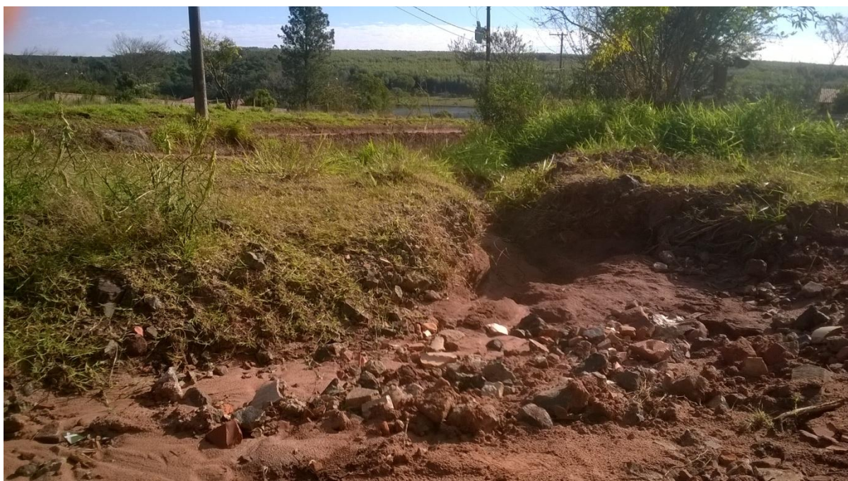
Figura 15: Ravina em avenida do bairro Parque dos Lagos. Foto retirada em 19 de julho de 2017. Autora: Natalí de Gregorio.
