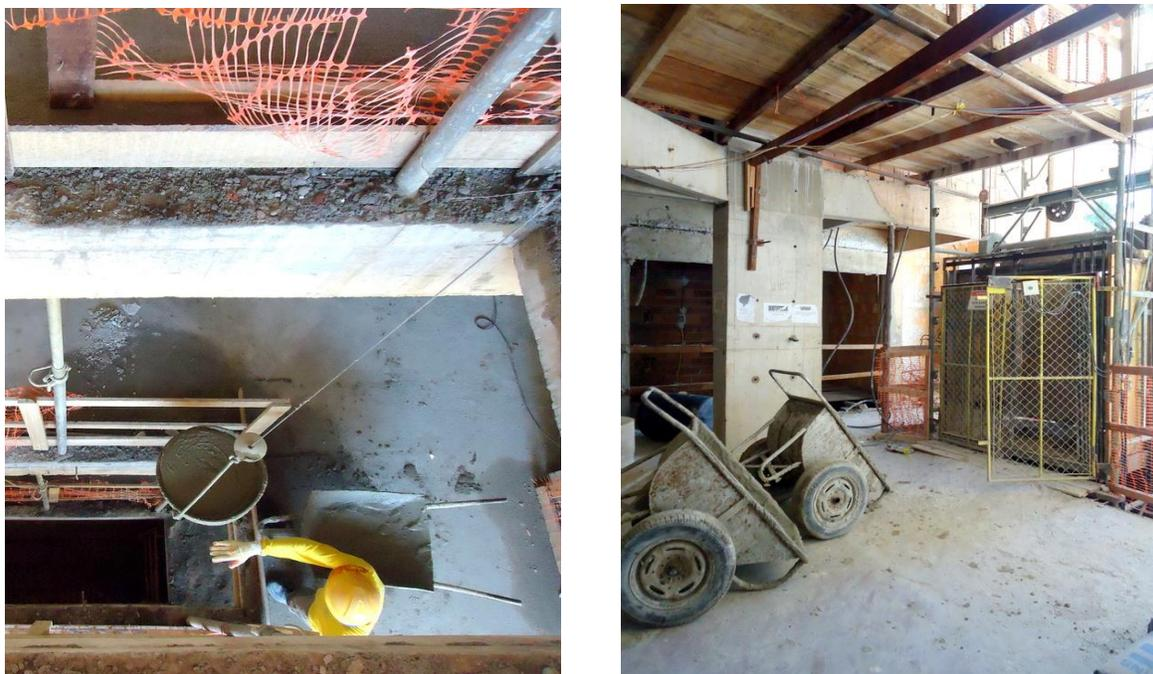
Figura 4.5 e 4.6 – Equipamentos para transporte vertical e horizontal
