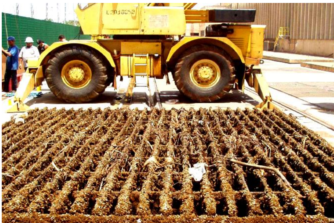
Figura 11 - Grade de tomada d'água de usina hidrelétrica infestada por mexilhões-dourados.
