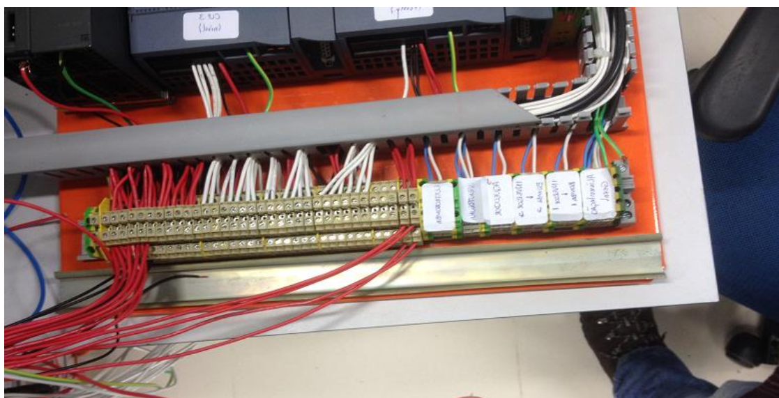
Figura 12 - Bornes do painel no início da montagem
