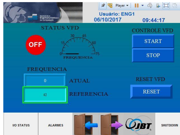
FIGURA 29: Tela de principal de comando do variador
