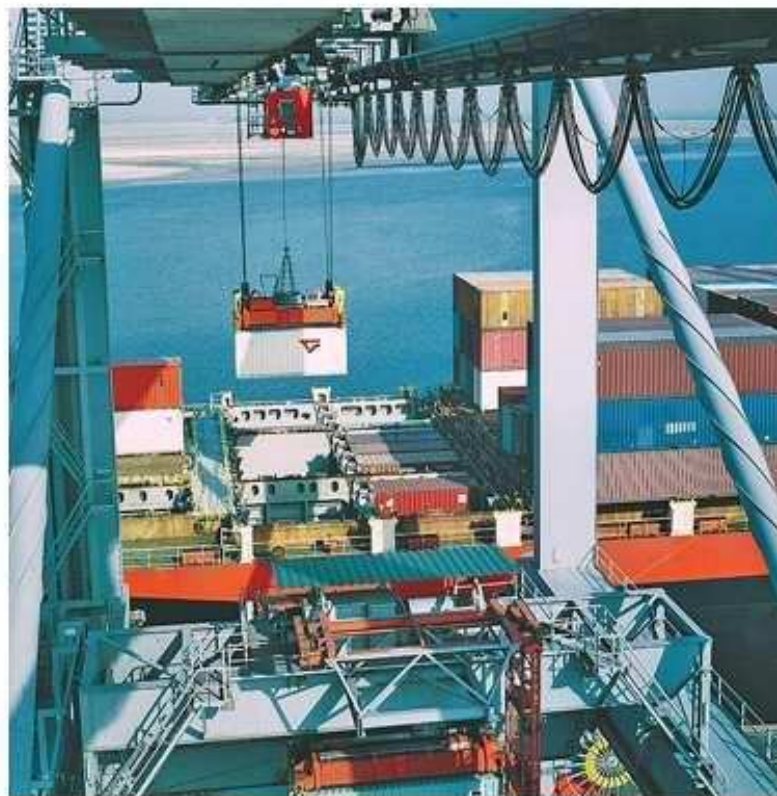
Figura 14 - Ponte Rolante ( crane ) transportadora de container , instalada em um porto.
