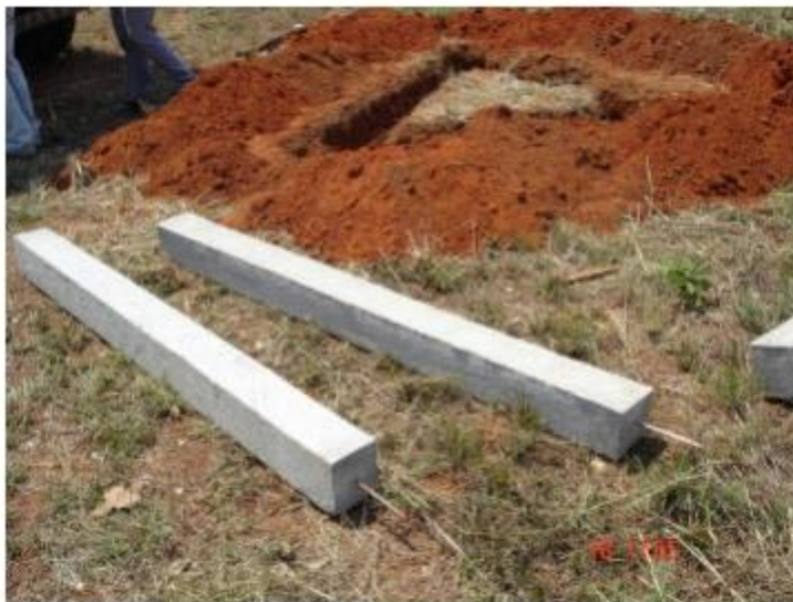
Figura 5-6 Malha com Hastes Concretadas [29]
