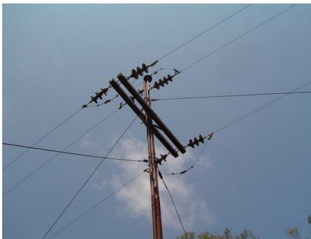
**Figura 5-4: Estrutura do Tipo E.**
