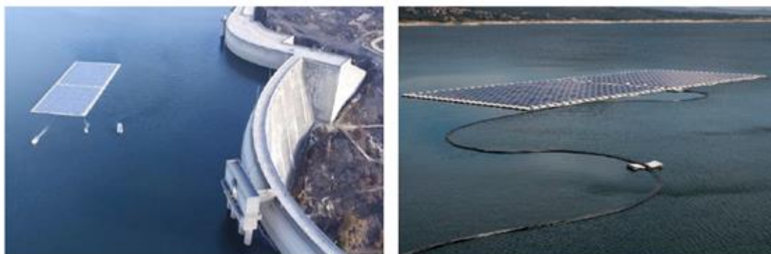
Figura 20: Usina Piloto Flutuante em Alto Rabagão, Portugal.
