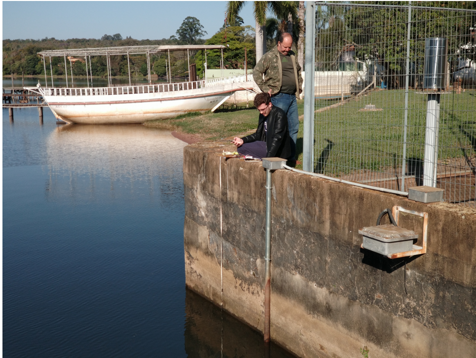
Figura 10 – Testes feitos na barragem na posição 2
