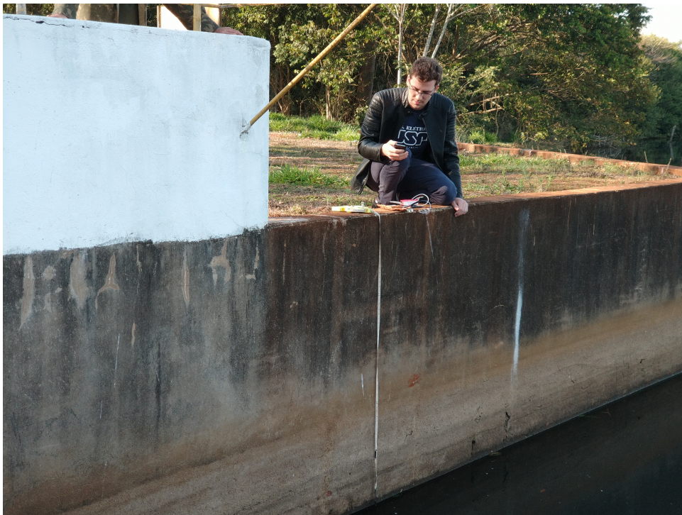
Figura 9 – Testes feitos na barragem na posição 1
