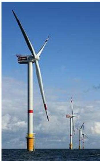
Figura 3. 3 - Aerogerador de eixo horizontal [10]
