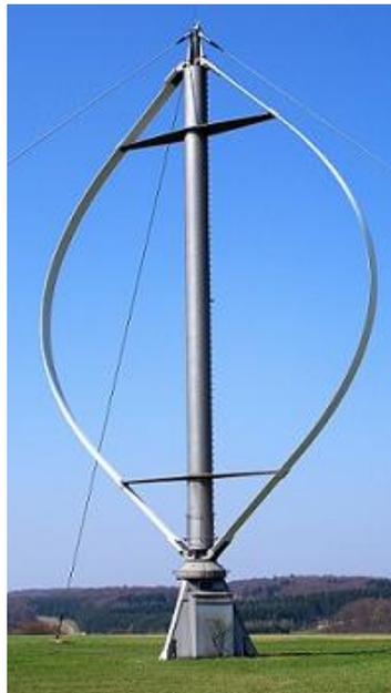
Figura 3. 1 - Aerogerador de eixo vertical tipo Darrieus [10]
