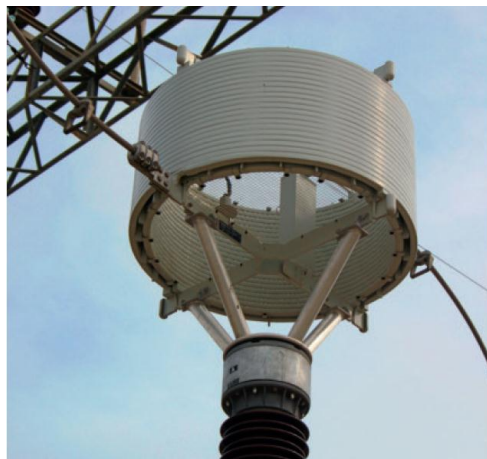
Figura 42 - Bobina de bloqueio [38]
