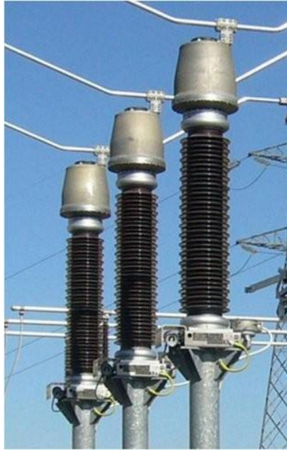
Figura 40 - Transformador de potencial indutivo [34]
