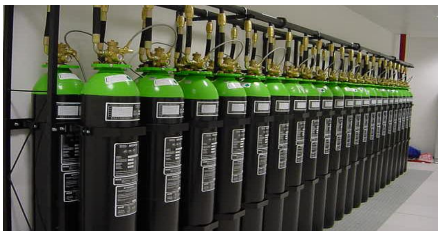
Figura 74 - Cilindros para sistema fixo de CO 2 [66]
