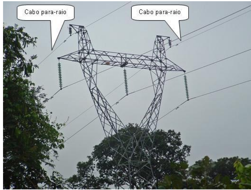
Figura 23 - Cabos-guarda aéreos ou cabos para-raios [13]
