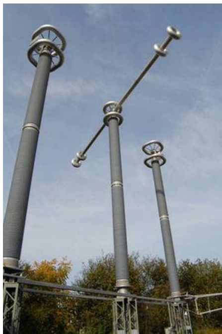
Figura 32 - Chave seccionadora com abertura dupla lateral e anéis para redução de efeito Corona [28]
