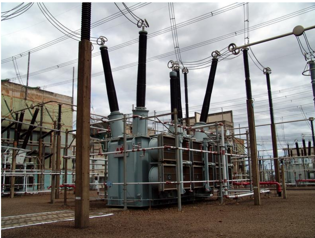
Figura 12 – Imagem de um transformador de alta potência de 500kV, 350MVA.
