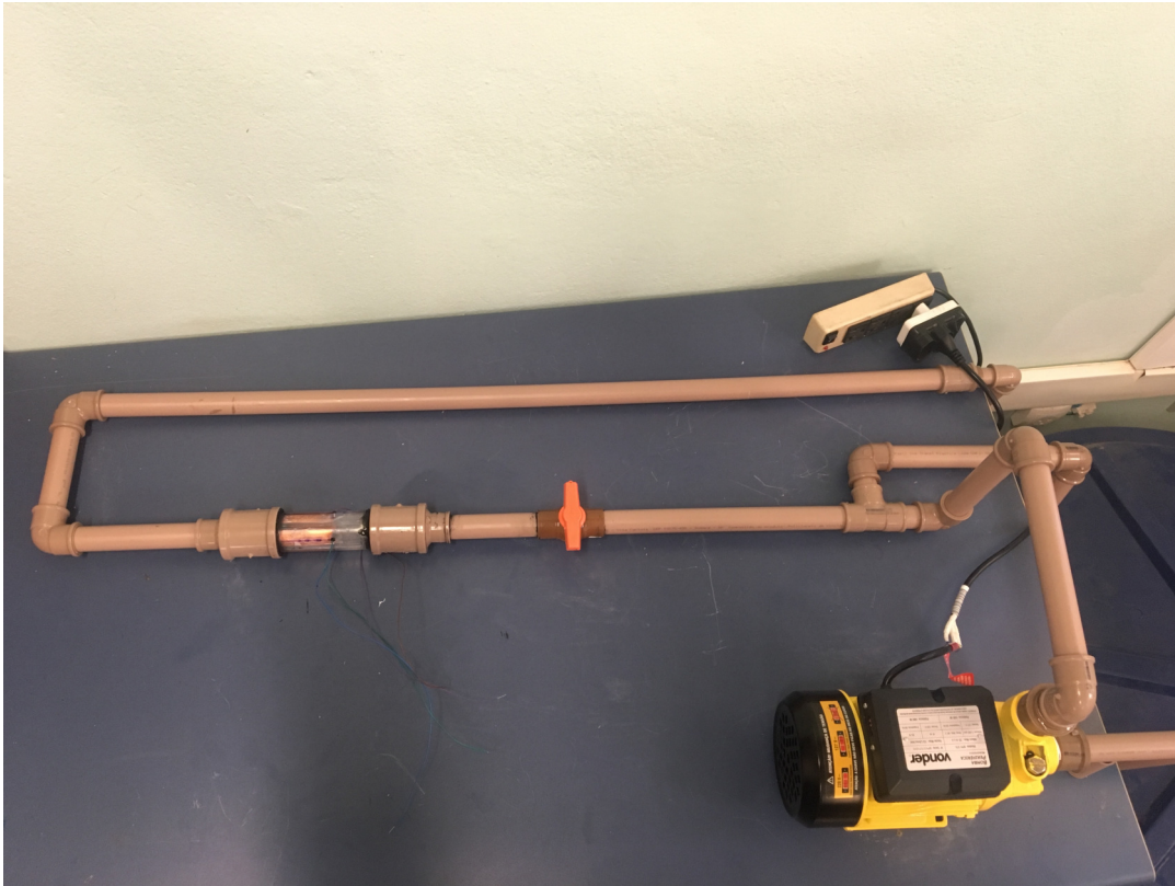
Figura 21: Montagem do sistema hidráulico.
