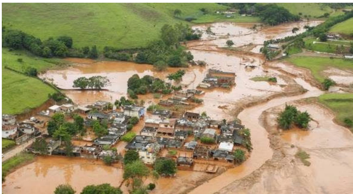
Figura 7 - Rompimento da barragem São Francisco atinge a Zona da Mata mineira
