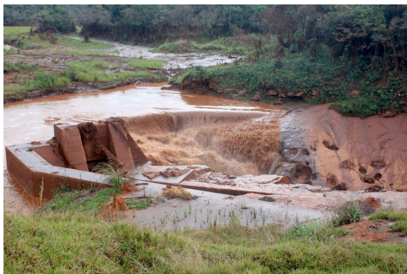
Figura 6 - Barragem do Fundão
