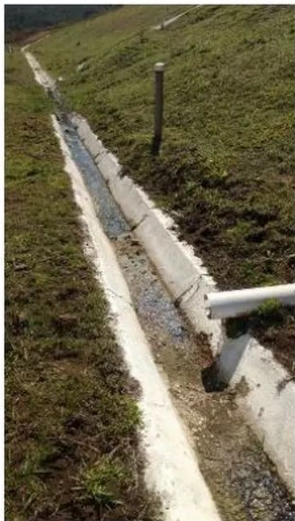
Foto 12 – Surgência de água na canaleta próxima a segunda trincheira (da ombreira direita para esquerda) na bermã na EL. 899 m.
