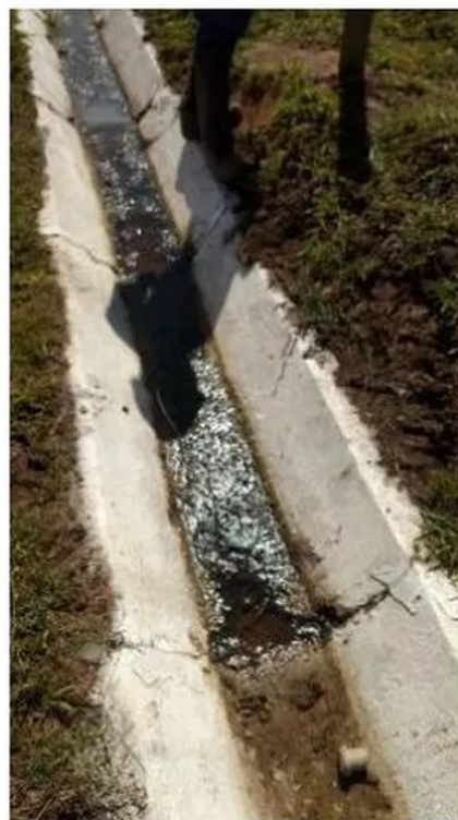
Foto 12 – Surgência de água na canaleta próxima a segunda trincheira (da ombreira direita para esquerda) na bermã na EL. 899 m.
