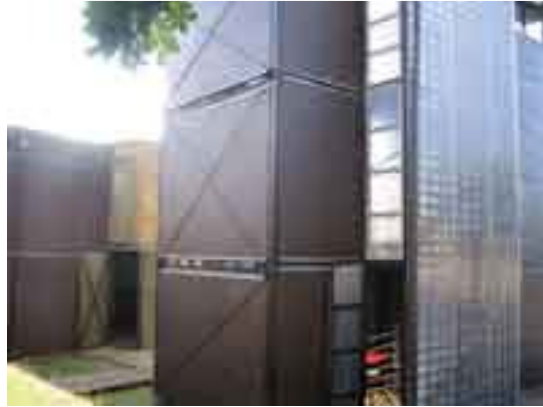
Figura 11 - Fachada de chapa ondulada de fibra de vidro translúcida.
