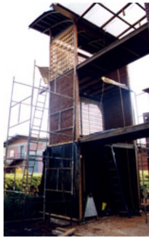
Figura 6 - Construção da Unidade Experimental de Habitação 001.
