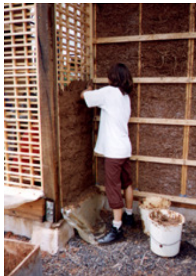
Figura 9 - Barreamento de taipa de mão.
