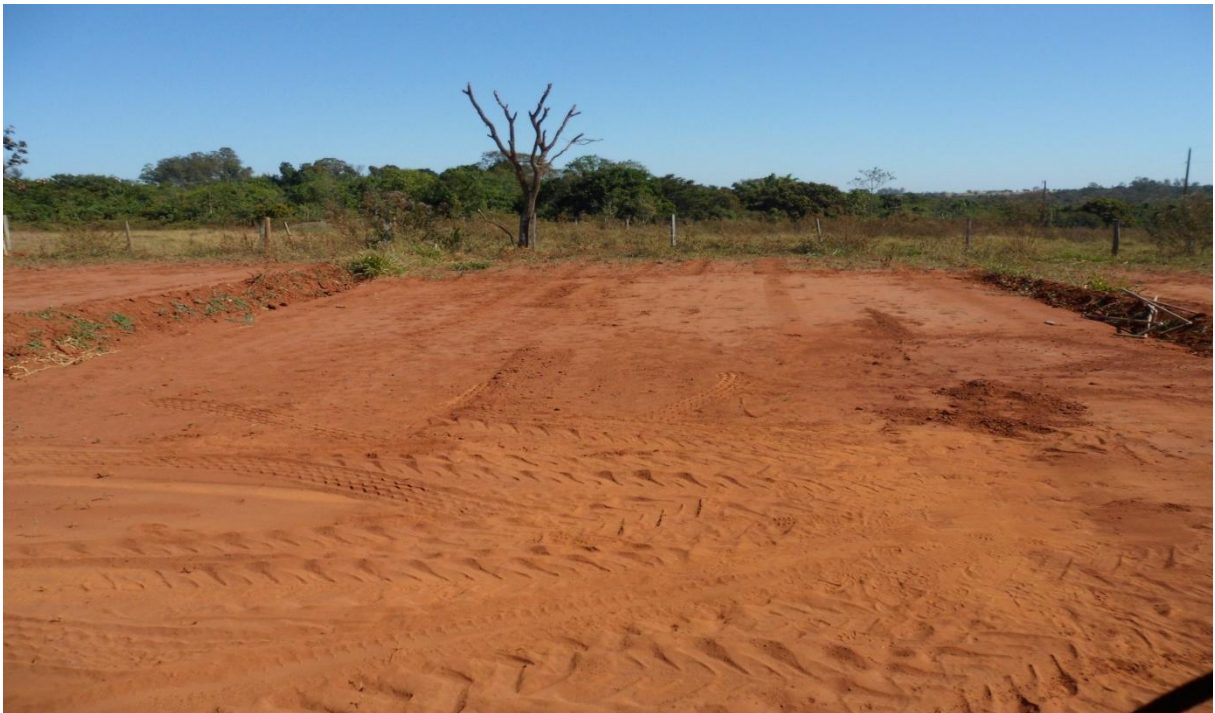
Figura 4 – Movimentação de solo, terraplenagem.
