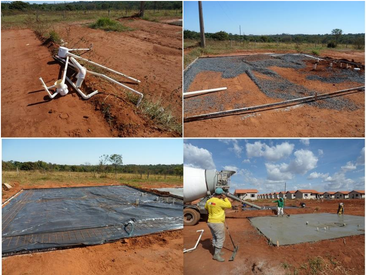
Figura 5 – Produção da estrutura de fundação
