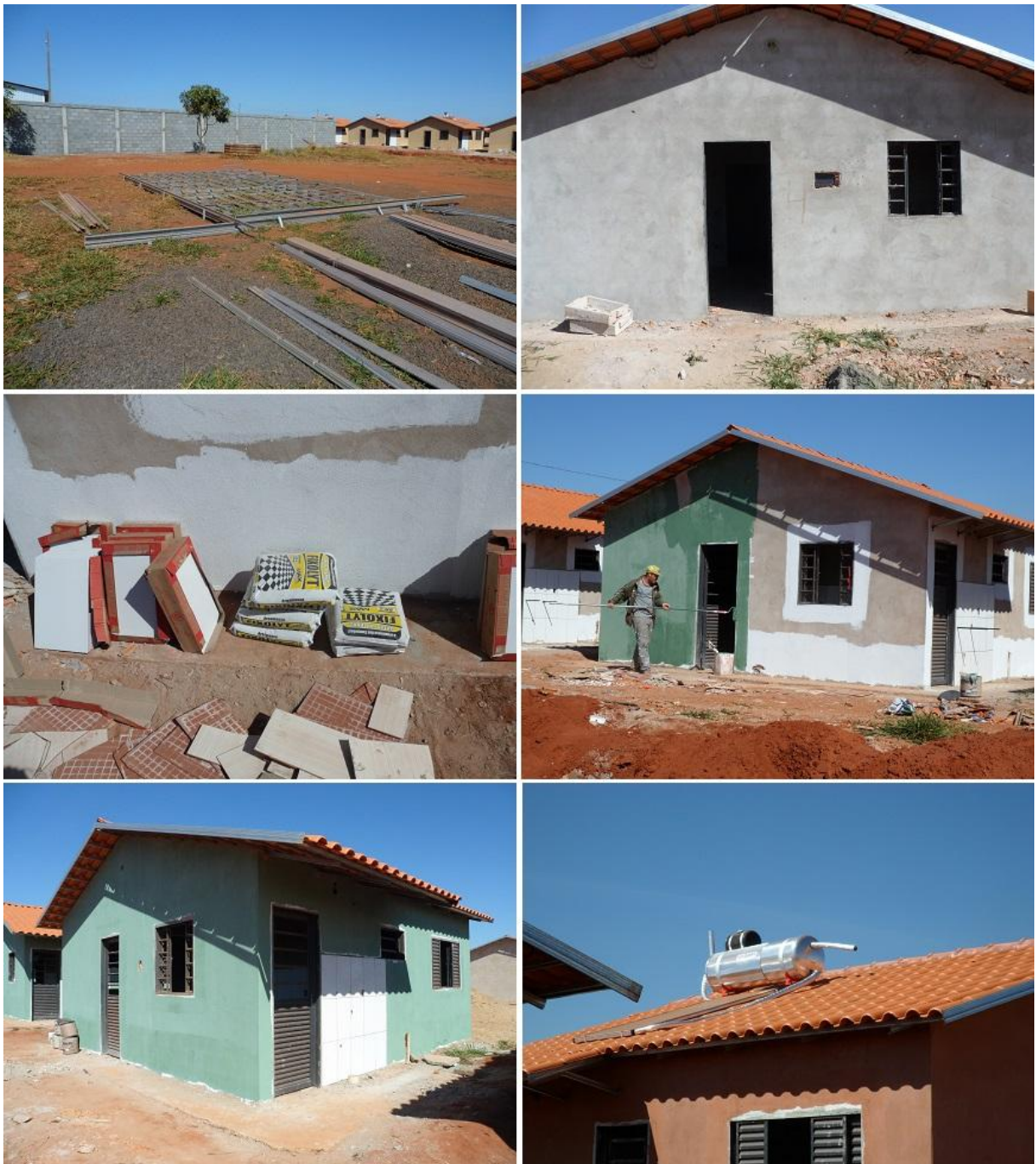
Figura 7 – Cobertura, pintura, pisos e azulejos, vidros e aquecimento solar.
