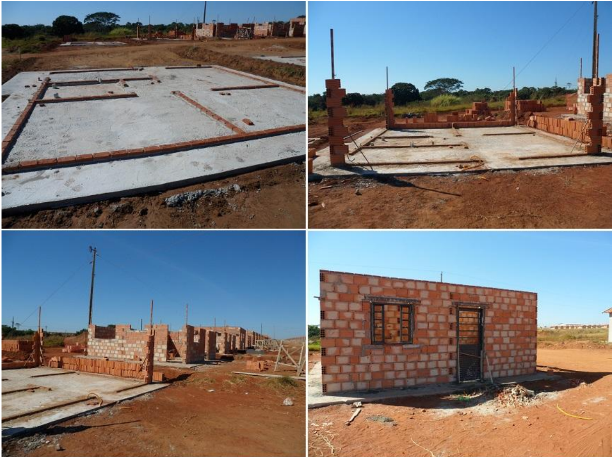
Figura 6 – Produção de alvenaria estrutural
