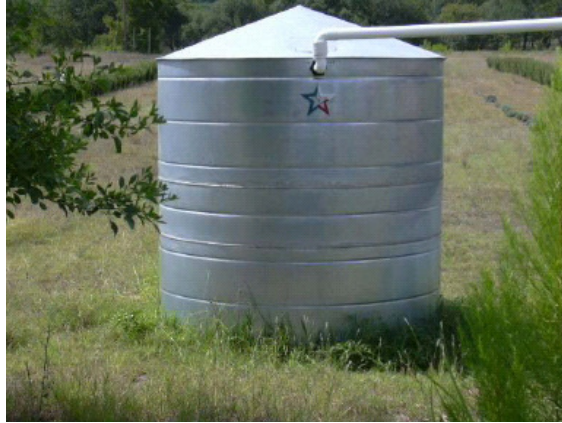
Figura 3.24 – Cisterna Metálica. FONTE: Campos, 2004
