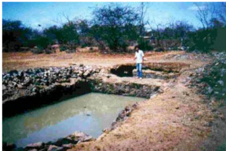
Figura 3.11 – Represa para armazenar água de escoamento superficial comumente utilizadas em regiões semi-áridas FONTE: Gnadlinger (2000)
