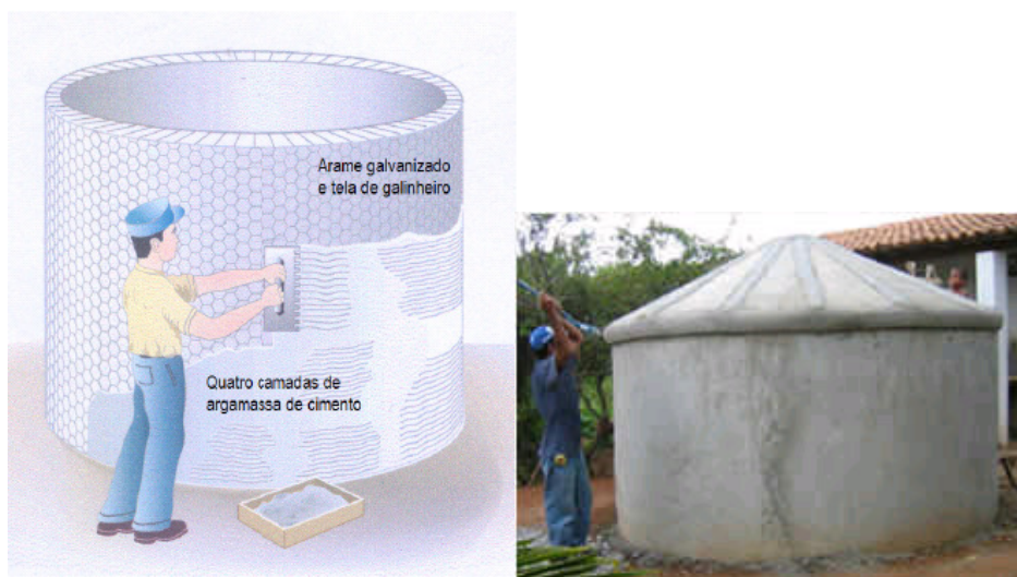
Figura 3.23 – Reservatórios de Ferrocimento.
