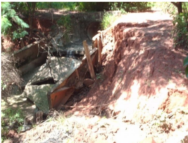
Figura 133 - Ponto 1 (fonte: Marques, M.M. da S.; Tarpani, R.R.Z) em 13/02/2008
