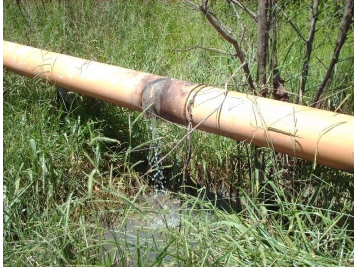
Figura 155 - Ponto 3 fonte: Marques, M.M. da S.; Tarpani, R.R.Z) em 13/02/2008
