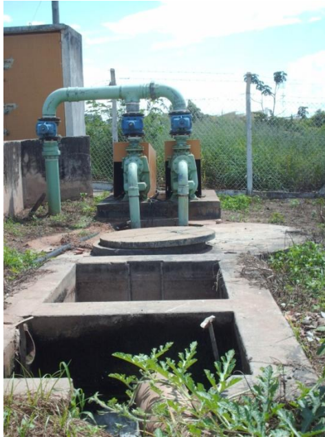
Figura 177 - Ponto 3 (fonte: Marques, M.M. da S.; Tarpani, R.R.Z) em 13/02/2008
