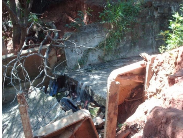
Figura 122 - Ponto1 (fonte: Marques, M.M. da S.; Tarpani, R.R.Z.) em 13/02/2008
