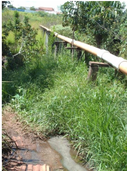
Figura 166 - Ponto 3 (fonte: Marques, M.M. da S.; Tarpani, R.R.Z) em 13/02/2008
