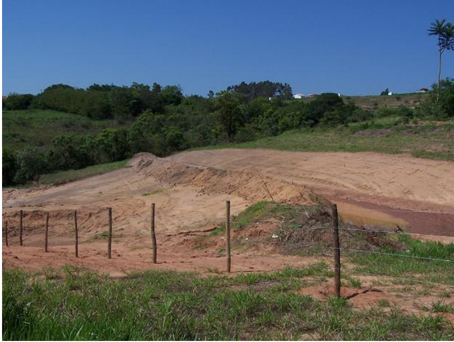
Figura 66: Área estabilizada por aterramento da feição, em novembro de 2007
