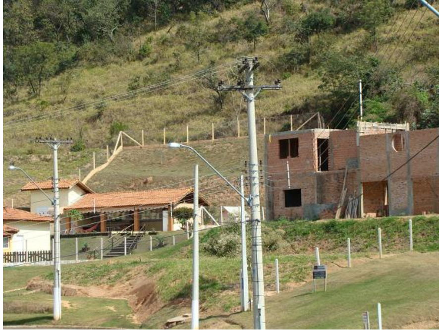
Figura 63: Residências construídas na encosta, com alto risco de ocorrência de processos erosivos – Julho de 2008
