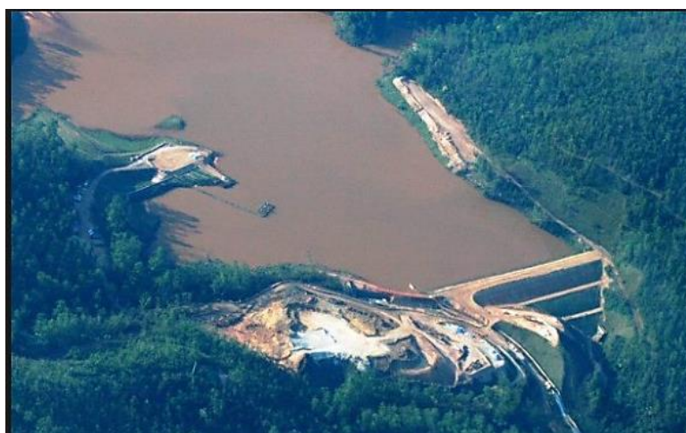
Figura 6 – Aspecto geral da Barragem de Germano, em Mariana, antes do desastre.
