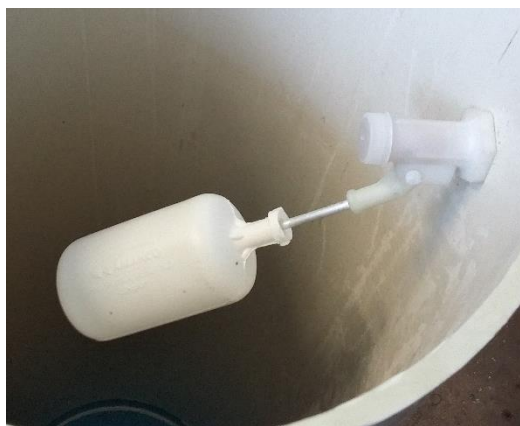
Figura 24. Detalhe da boia instalada no filtro contínuo.
