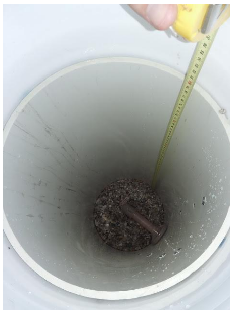
Figura 6. Preenchimento do filtro com pedregulho.
