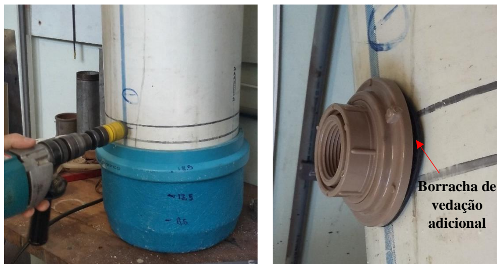
Figura 18. Colocação do adaptador de caixa d'água. (1) Detalhe da serra copo. (2) Detalhe do acessório.
