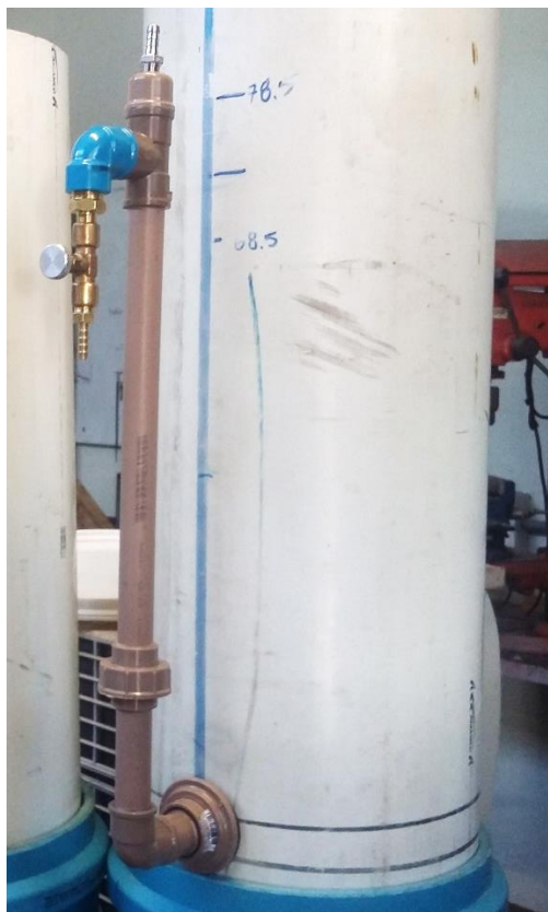
Figura 25. Saída de água do filtro contínuo finalizada.
