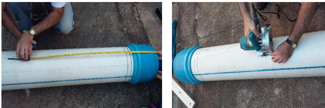
Figura 16. Medição e corte do corpo do filtro.
