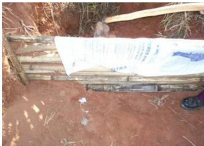
Figura 42: Barreira de bambu coberta com saco de ráfia (Francisco, 2011).
