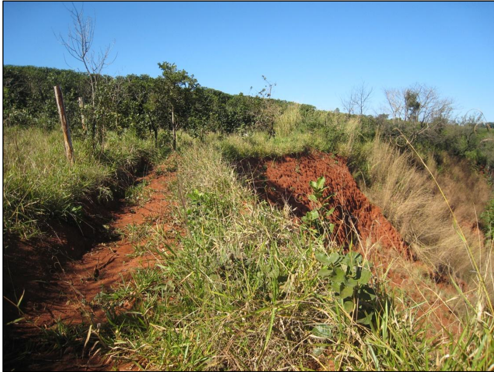
Figura 25: Vista da obra de drenagem remanescente a montante da voçoroca.
