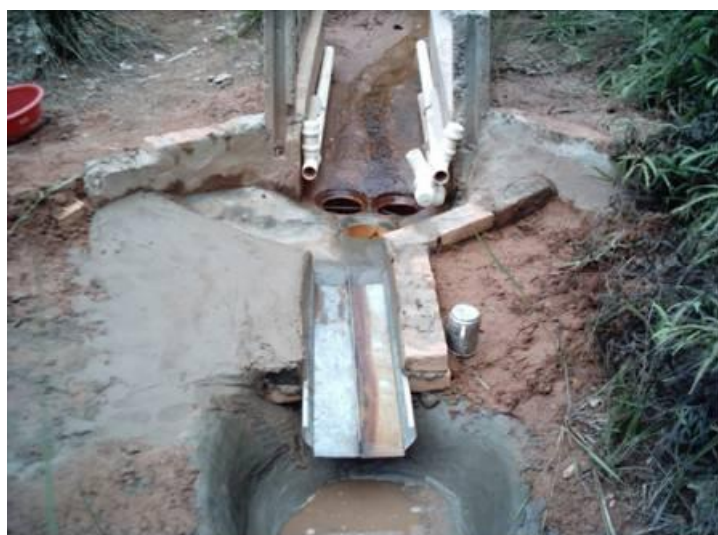
Figura 41: Vertedor montado no interior da voçoroca (Rocha, 2007).
