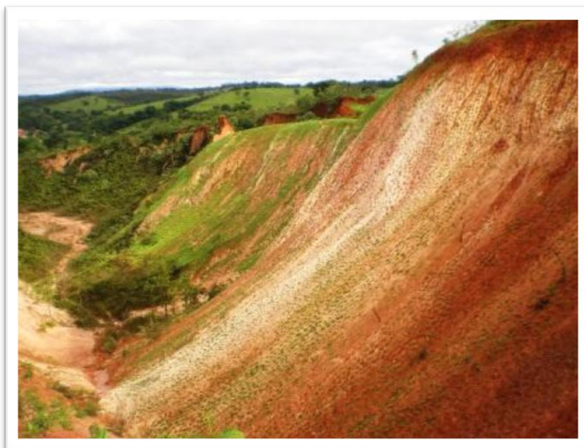
Figura 23: Talude suavizado, com coveamento e plantação de gramíneas. Essas atividades foram realizadas em 2008. (Disponível em: < http://www.projetomariadebarro.org.br/?Pagina=apresenta_noticia&Id=163 >, acesso em: 22 de outubro de 2015).
