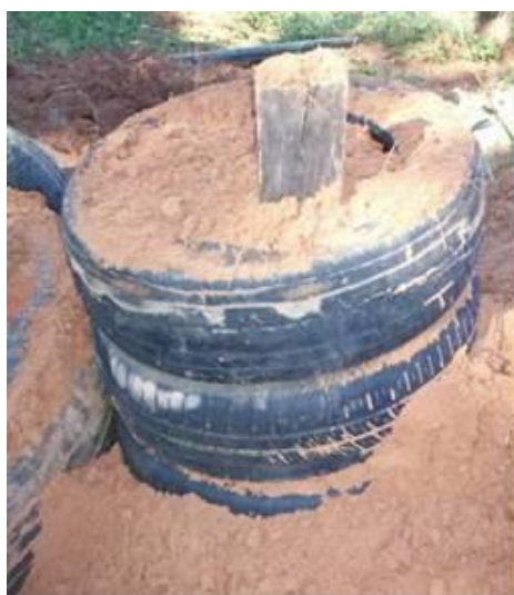
Figura 43: Barreira de pneus preenchida com terra (Francisco, 2011).
