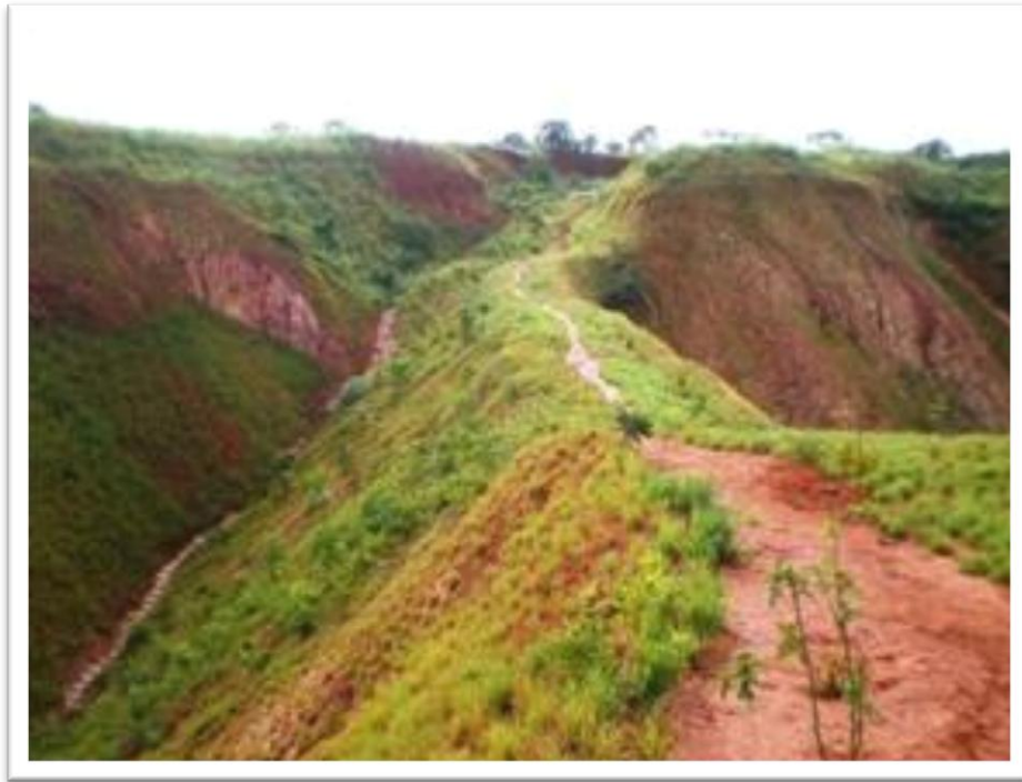
Figura 24: Vista de obras de drenagem na voçoroca, em 2009. (Disponível em: < http://www.projetomariadebarro.org.br/?Pagina=apresenta_noticia&Id=163 >, acesso em: 22 de outubro de 2015).
