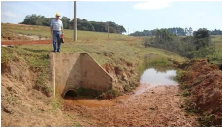
Figura 49: Cordão de nível construído na frente de uma saída de tubulação funcionando como um dissipador de energia tipo bacia de mergulho (ROTTA, 2012).
