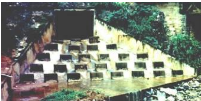
Figura 39: Dissipador de energia tipo bacia de impacto (Disponível em: http://lpeng.br.tripod.com/artigos/dissipadores_energia.htm , acesso em: 22 de outubro de 2015).
