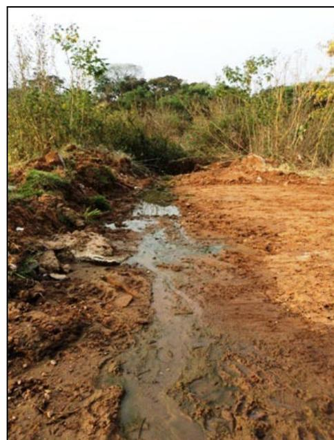
**Foto 6.3: Esgoto transbordado devido a entupimento de canalização de esgoto há três semanas sem atendimento da prefeitura.**
