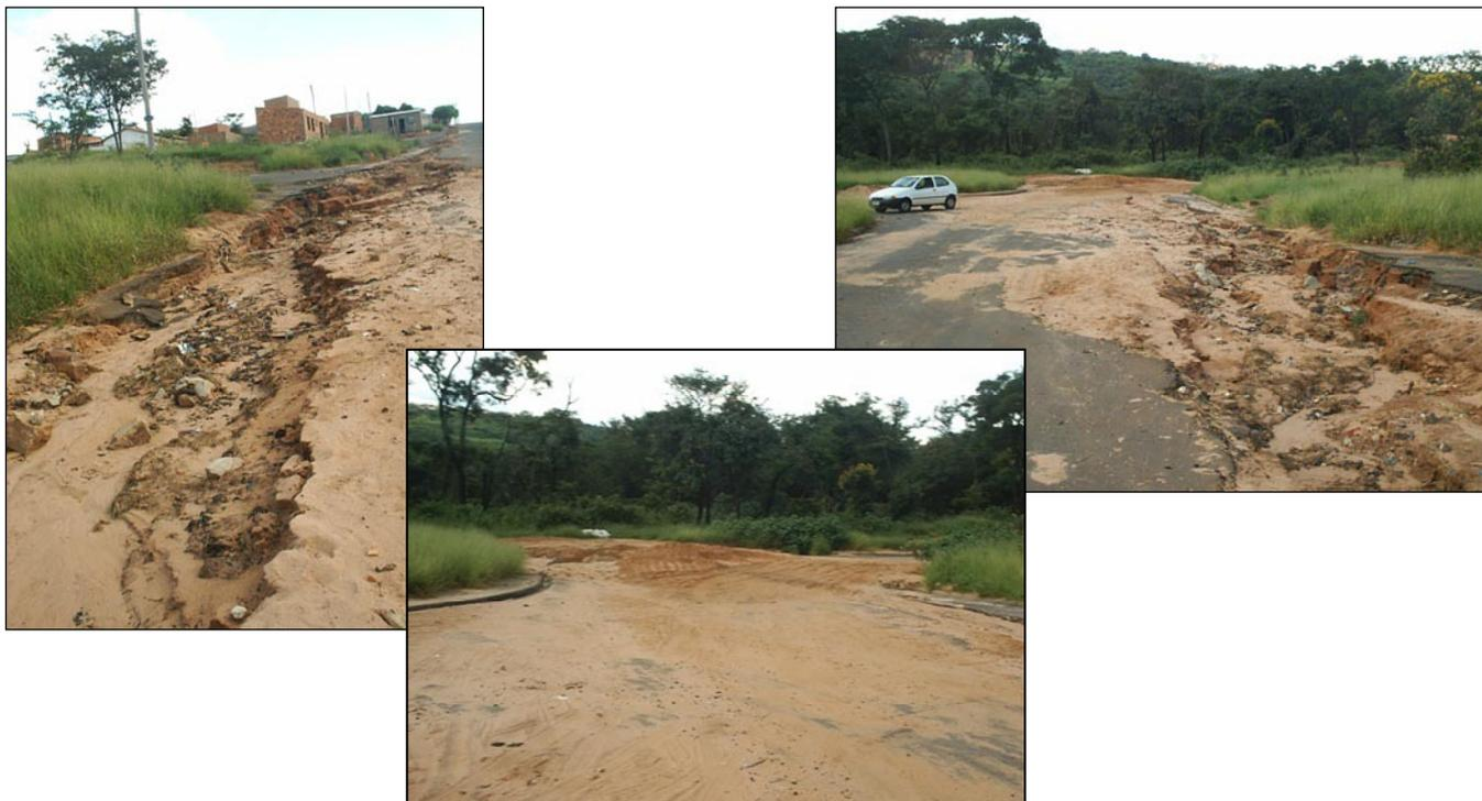
**Foto 7.30: Área onde foi implantada tubulação de esgoto após um mês. Carreamento de terra ao longo da vala aberta até o fim da via - 24/02/2010.**
