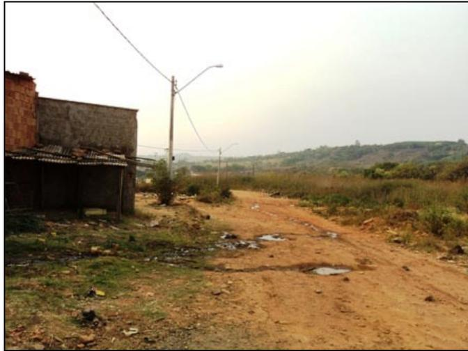
**Foto 6.4:** Área do bairro Antenor Garcia. Conseqüência da via não asfaltada e sem drenagem.
