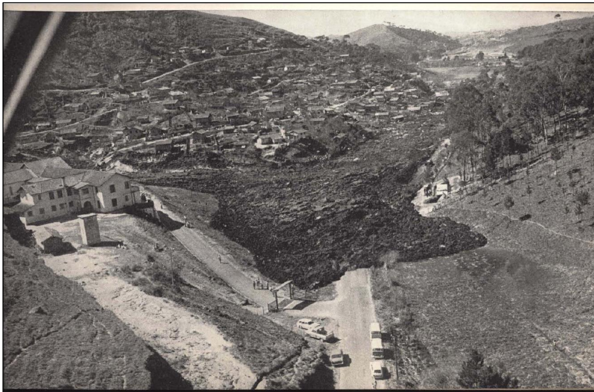
Figura 41 – Vista aérea do vale e do represamento da água do córrego Piracuama pelo movimento de massa em 1972 no município de Campos do Jordão-SP
