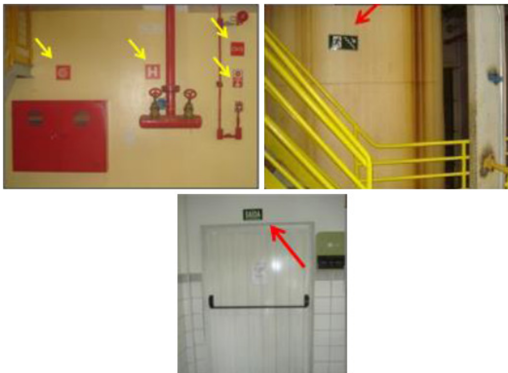
Figura 15: Instalação das placas para rotas de fuga.
