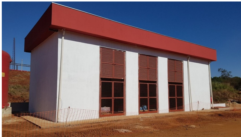
Figura 12: Casa de Bombas.
