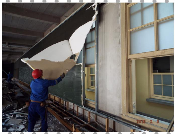
Retirada do revestimento e dos respectivos suportes metálicos para descarte.
