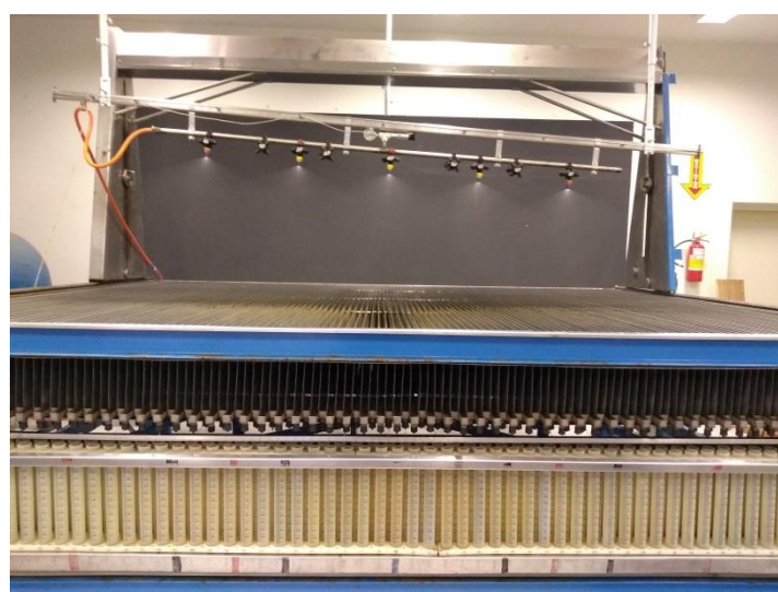
Figura 6. Barra inclinada em funcionamento.
